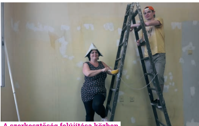
A szerkesztőség felújítása közben
